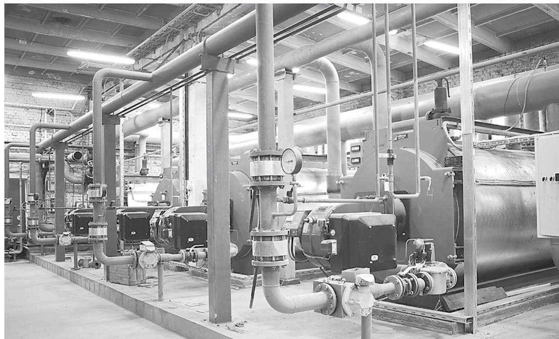
В рамках энергосервисного контракта полностью модернизировано 16 котельных.
