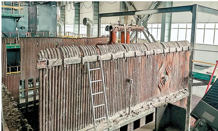
Новое оборудование более мощное, что даст резерв для подключения новых домов, более экономичное, экологичное и автоматизированное. В 2023 году в реконструкцию вывели котел №8. Старое котловое оборудование демонтировали, после чего выполнили монтаж нового котла, вышли на пусконаладочные работы.
