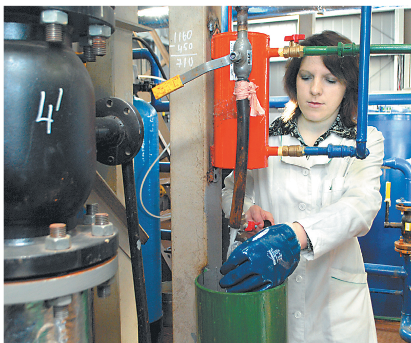
Горячая вода получается из холодной, приобретаемой у ОАО «Нижегородский водоканал». Поэтому берутся еще и пробы исходной водопроводной воды.
