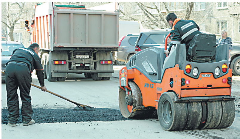
Асфальт сейчас укладывается по новой технологии в два слоя.
