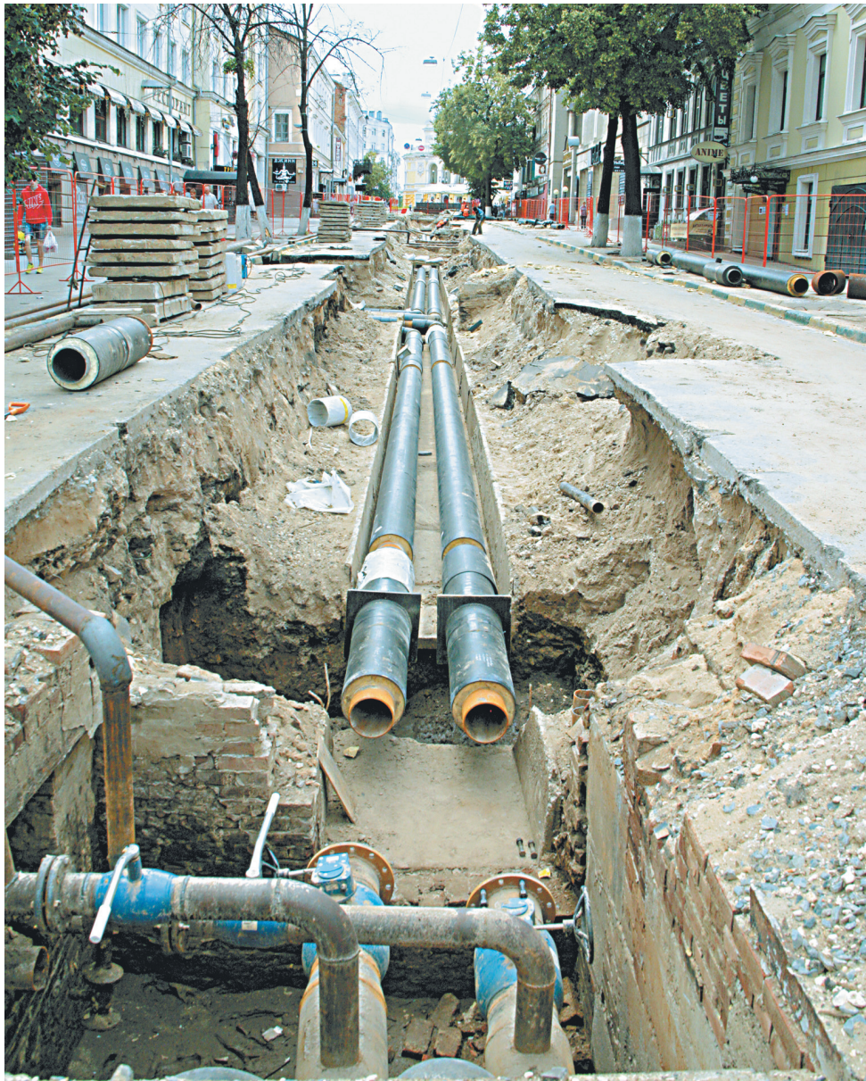
Реконструкция теплотрассы на ул. Пискунова.
