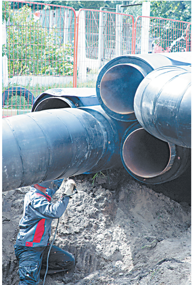
Замена магистральной теплотрассы на улице Буревестника, 17 (Московский район)
