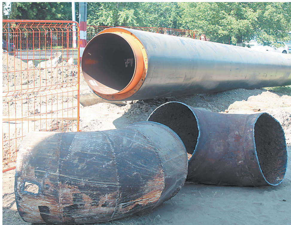
При прокладке теплотрассы используются предизолированные трубы в пенополиуретановой изоляции.
