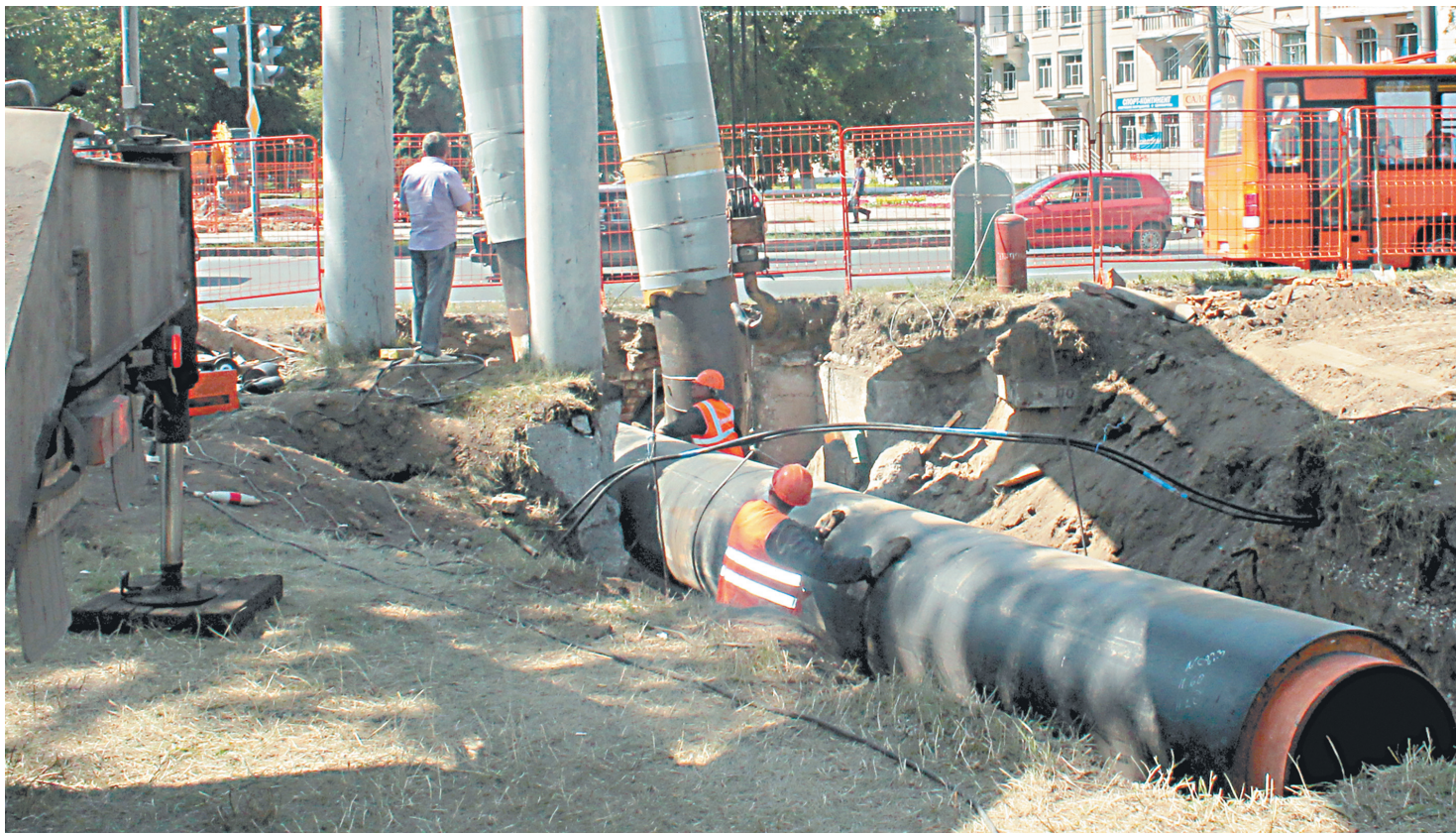
Ремонт магистральной теплотрассы на улице Коминтерна завершён 9 июля.
