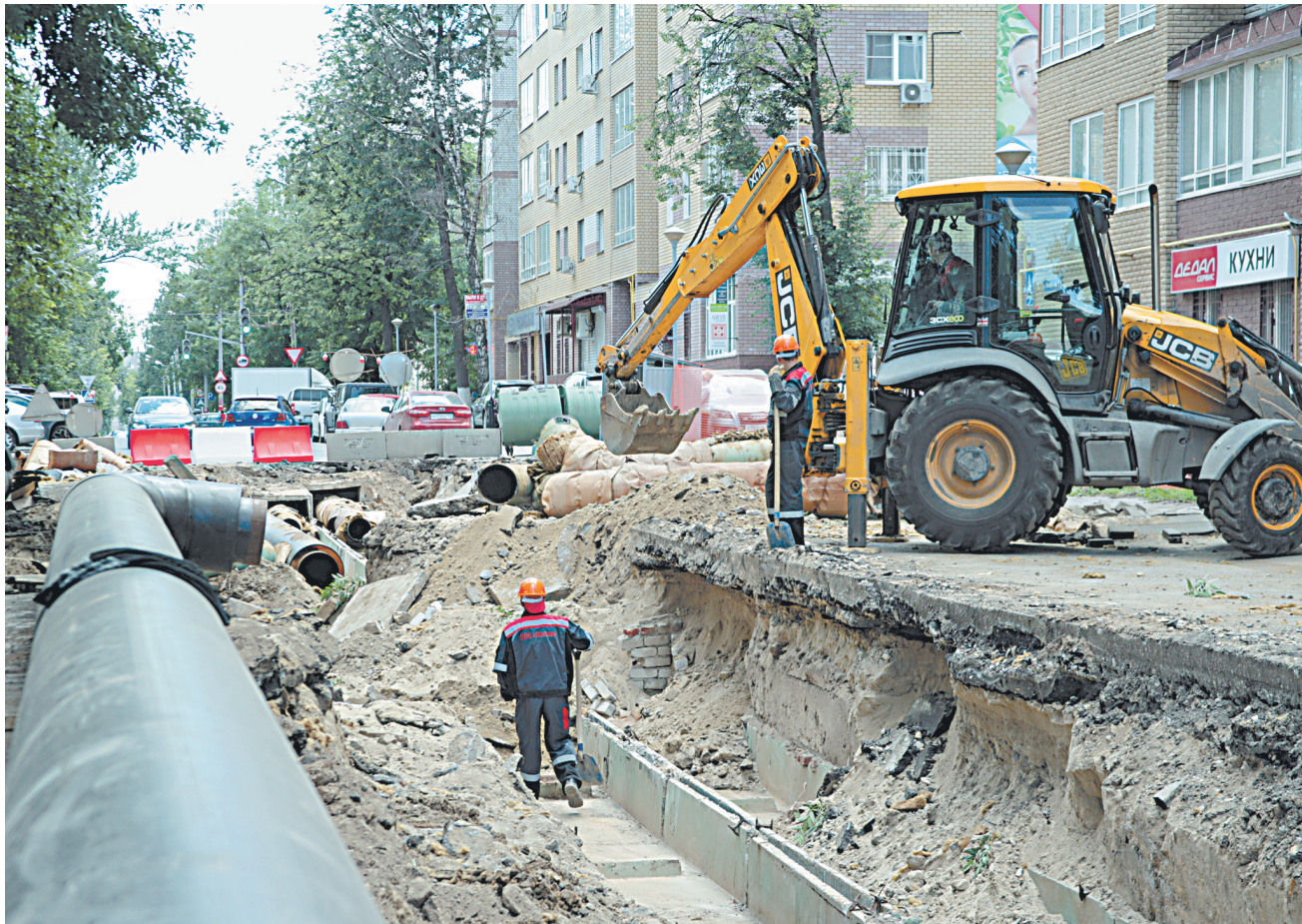
Реконструкция участка теплотрассы на улице Ижорской, 18.
