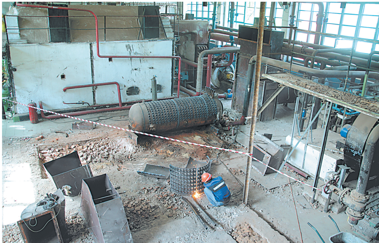
Демонтаж оборудования в котельной на проспекте Ленина, 5а.
