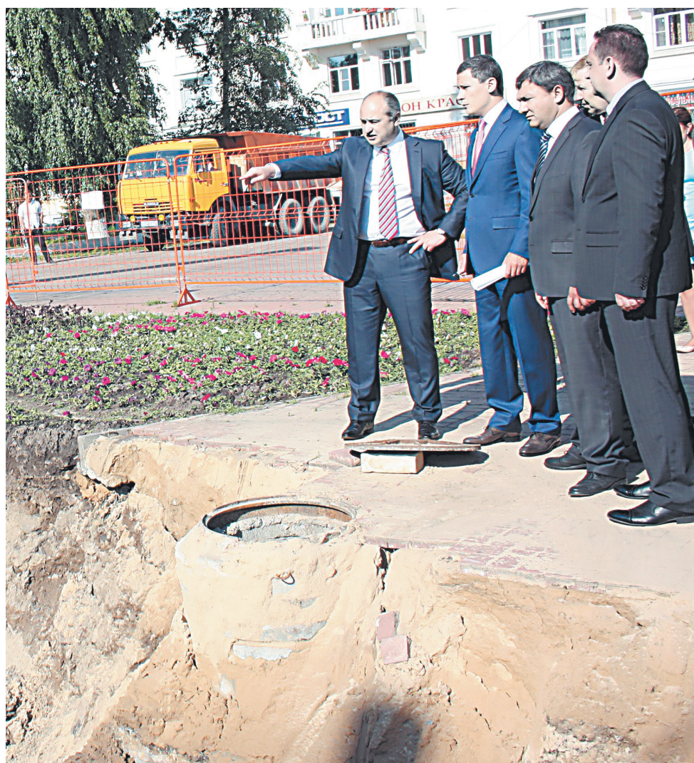
Участок ремонта теплотрассы на ул. 50 лет Победы.
