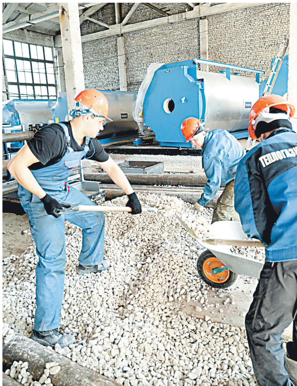
Работа по реконструкции котельной на ул. Баранова, 11.
