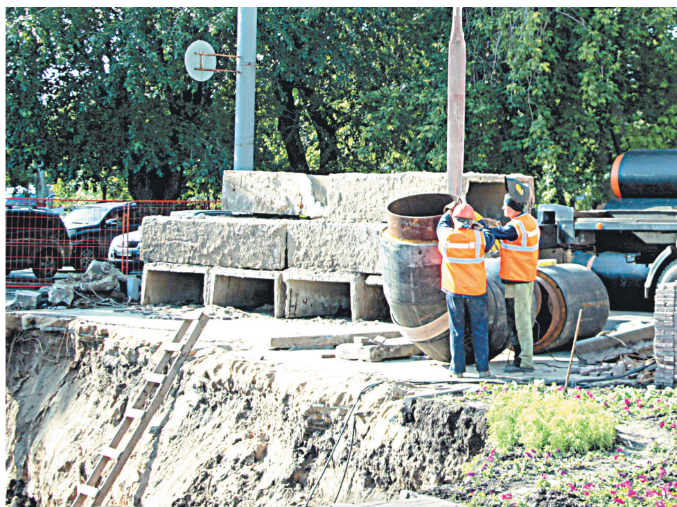
При прокладке теплотрассы используются предизолированные трубы в пенополиуретановой изоляции.
