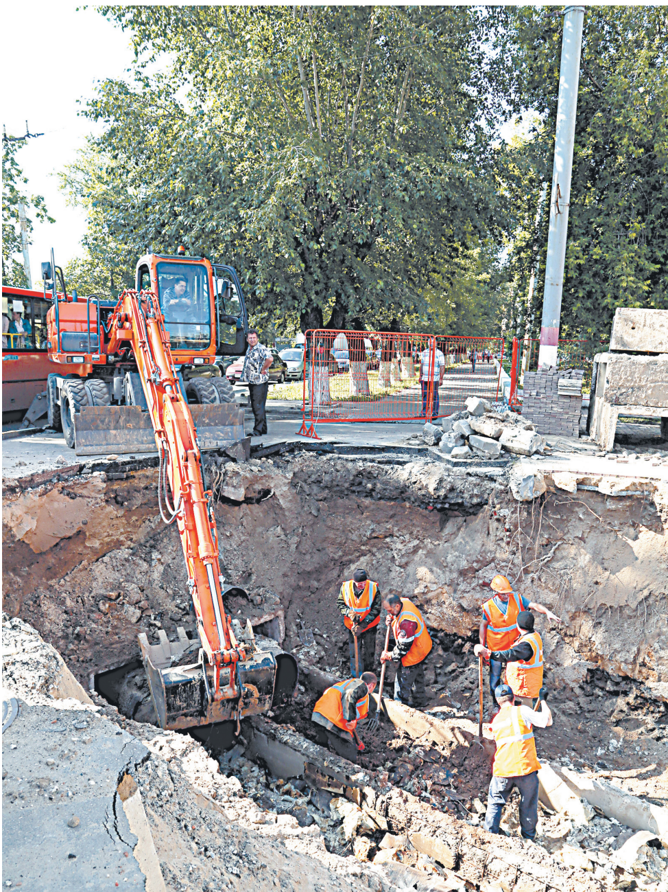
Замена теплотрассы на ул. 50 лет Победы.
