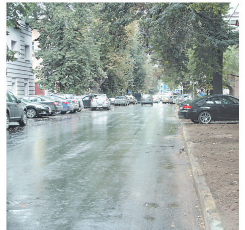
Ремонт завершился в назначенный срок, теперь теплотрассы в этом квартале отвечают всем требованиям надежности.
