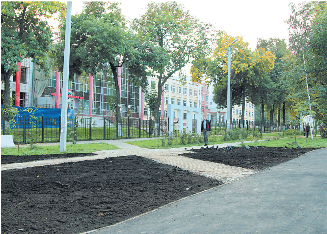
Завершены работы по благоустройству на улице Тунгусской (Нижегородский район).
