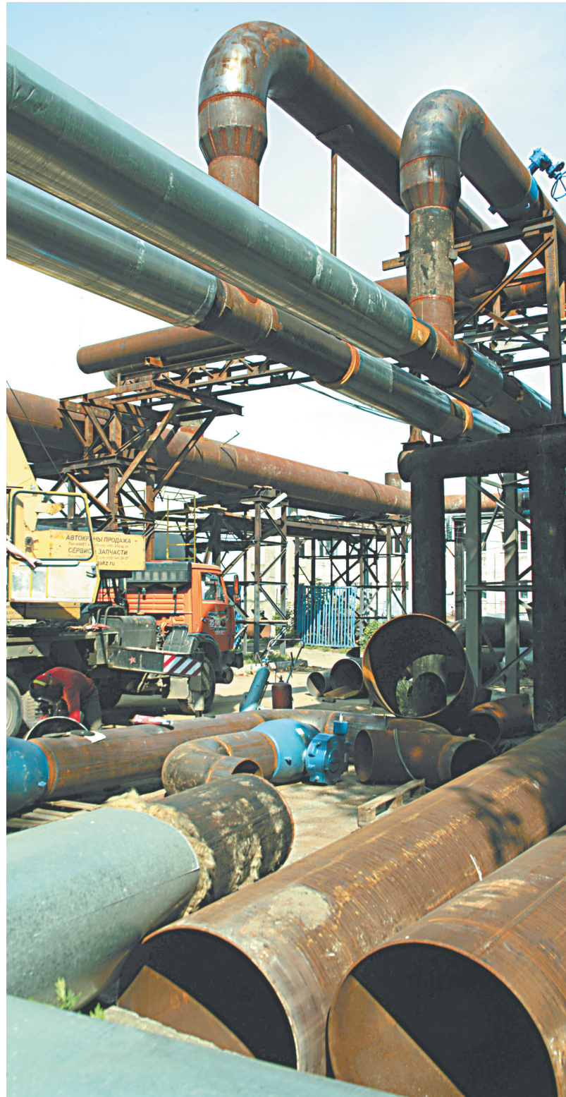
Ремонт коллекторов на Нагорной теплоцентраль.
